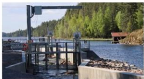
Omkring 3,5 kubikmeter vatten forslar genom fiskvägen varje sekund.
