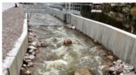
3 000 liter i sekunden forsar fram sedan dammuckorna har öppnats i den nya fiskvägen.
