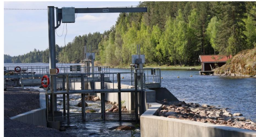
Fiskvägen i Laxberg i Boxholms kommun har kostat drygt 40 miljoner kronor.
