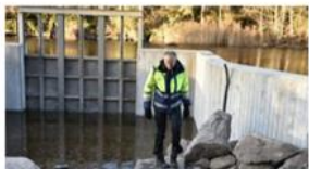
Dammuckorna vid fiskvägen i Laxberg öppnades den 12 februari.
